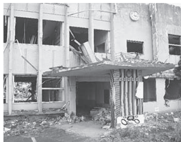
被害にあった大槌町役場 岩手県沿岸部にある大槌町。庁舎が津波により全壊した。
