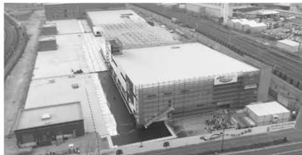
建設がすすむ竜華水みらいセンター この巨大施設の防災機能強化を
